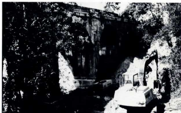
CD 51 - Pont de Chaysse
