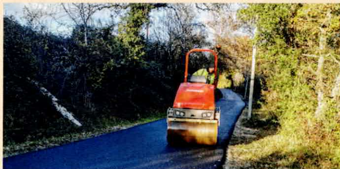
Travaux de goudronnage, chemin de Ribautes
