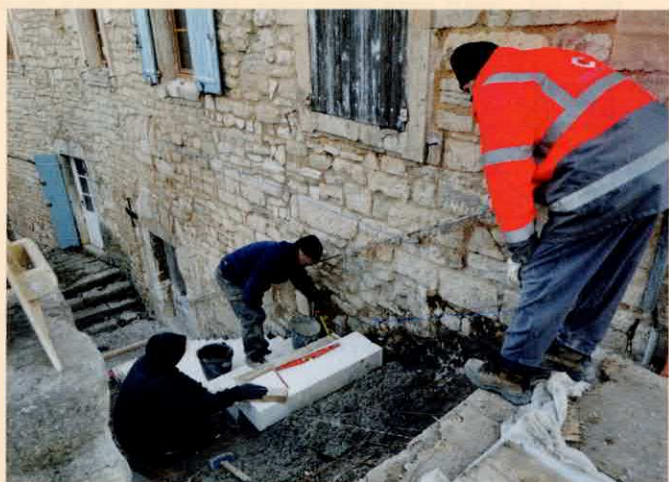
Escalier de la Caladette de Canvien
