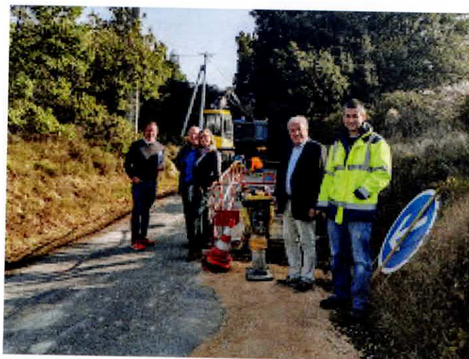
Réunion de chantier Barjac
