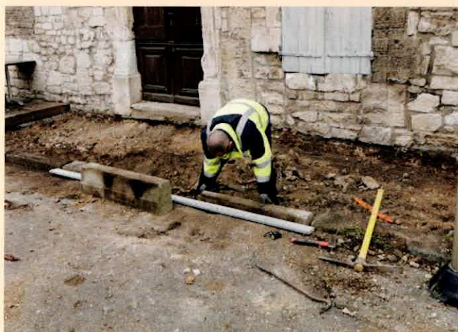
Travaux des services techniques
